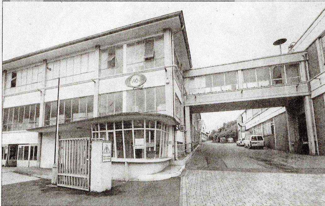
Neben den Hallen der 1868 gegründeten Kapselabrik, deren Standort zurzeit diskutiert wird, steht noch heute das Geburtshaus von Nackenheims berühmtem Sohn Carl Zuckmayer. ■ Foto: Eßling
